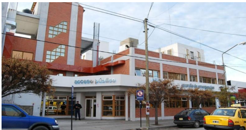
Acceso a la Guardia de Emergencia año 2009.
